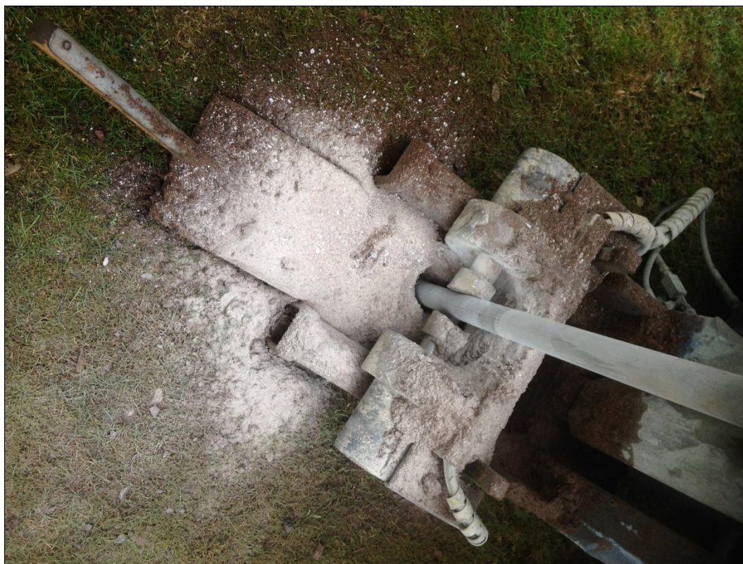
Figur 4. Utförd sondering vid provpunkt 17ÅF03 påvisade att borrhstoppet troligtvis berodde på underliggande berg. Foto: Infrastructure AB 2017.
